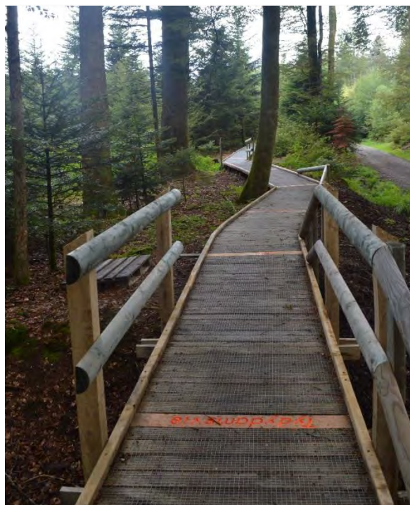
Figure 11 Le platelage garni d'un treillis est adapté à la circulation de personnes en chaise roulante (© FVP).
