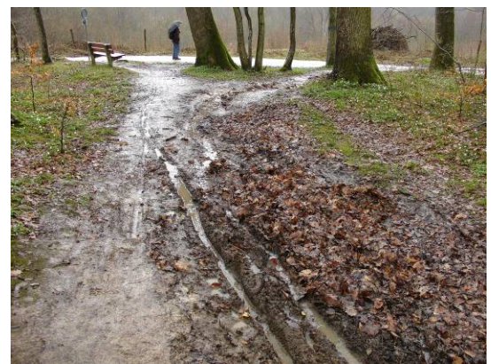
Fussweg bei nassem Wetter: Vernässungen und Umgehungspuren
